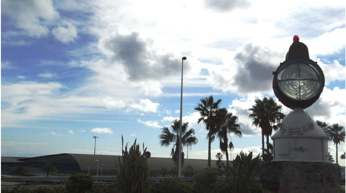
Aerofaro recuperado y rehabilitado en el Aeropuerto de Fuerteventura.
